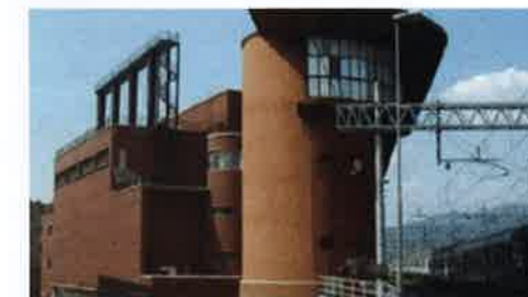
▲ 1927-34. Control de la Estación. Florencia. A. Mazzoni
